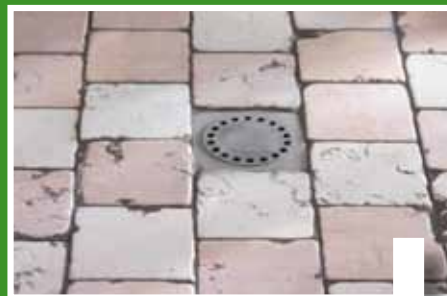
Aanbrengen frame renovatieput
